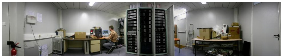
FIG. 2.10 – Vue panoramique à 360 degrés de la salle abritant le dédispenseur BON installé à Nançay avec le 'spectrometer' SerendipV, les 'dataservers' et le calculateur dédié.
